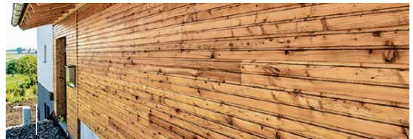
Das Fichtenholz an der Außenfassade haben Schädler mit einer Lasur behandelt, die auch vor dem Ausbleichen durch UV-Licht schützt.
