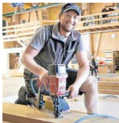
Norbert Raichart baut in der Halle die Wandelemente zusammen.
